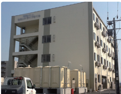
施工:2008.6 現場:福岡県(老人介護施設) 面積:1,750㎡、下地:アクリルウレタン(溶剤系)
