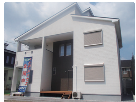
施工:2013.8 現場:奈良県(モデルハウス) 面積:200㎡、下地:サイディングボード
