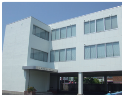
施工:2008.4 現場:奈良県(薬品会社研修施設) 面積:2,500㎡、下地:アクリルシリコン(水溶性)
