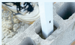
支柱を立てます。
