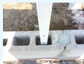
気温20℃の場合で5~6分で固定。3~4時間後、フェンス取り付け可能です。表面仕上げは普通モルタルでコテ仕上げしてください。
