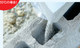
バットカタマル約500gを水を入れた上から直接投入します。(練り混ぜ不要)
