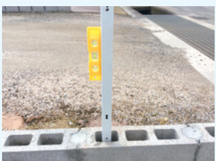
水準器で垂直になるよう調整します。
