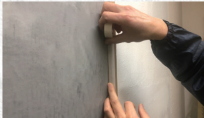
マスキングテープを柱・廻り縁・巾木に貼ります。
