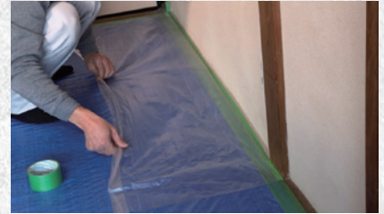
床部分はマスキナーで養生シート等で養生します。
