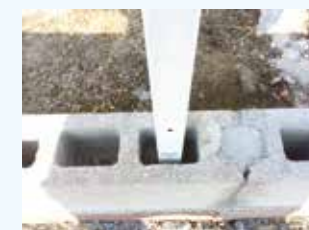
気温20℃の場合で5～6分で固定。 3～4時間後、フェンス取り付け可 能です。表面仕上げは普通モルタル でコテ仕上げしてください。
