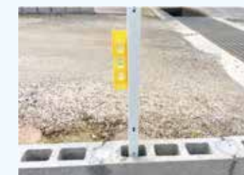
水準器で垂直になるよう調整します。
