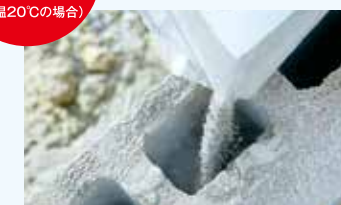
パットカタマル約500gを水を入 れた上から直接投入します。 (練り混ぜ不要)
