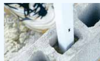
支柱を立てます。
