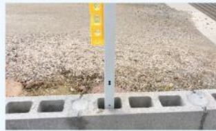
水準器で垂直になるよう調整します。
