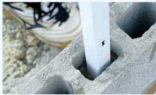
支柱を立てます。
