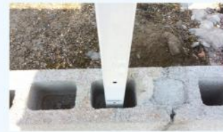
気温20℃の場合で5~6分で固定。3~4時間後、フェンス取り付け可能です。表面仕上げは普通モルタルでコテ仕上げしてください。
